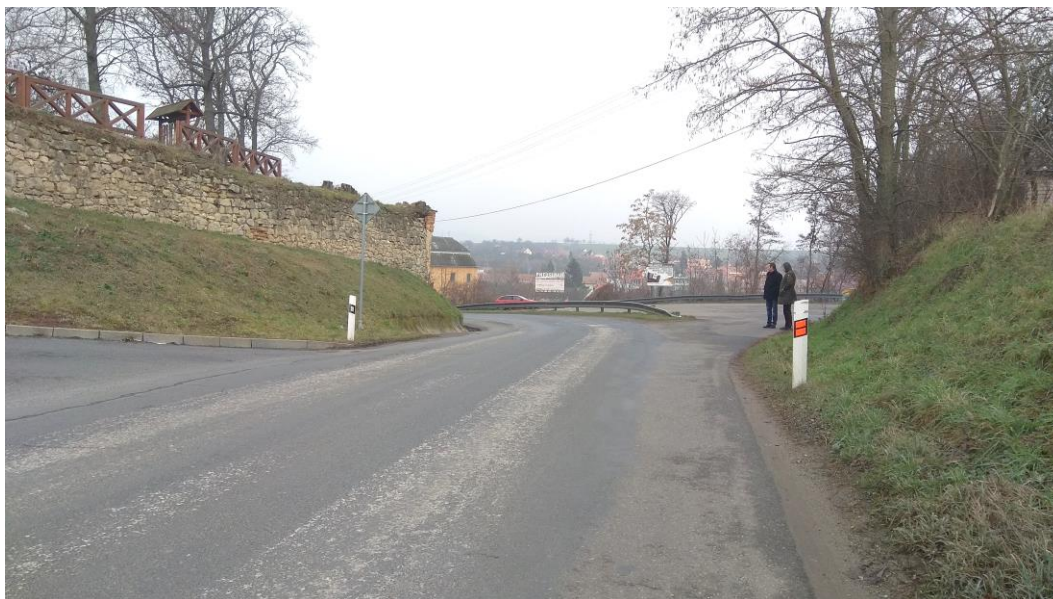
Obrázek 10: Pohled ze silnice III/42213 ve směru od Kyjova v místě levého odbočení na místní komunikaci.
