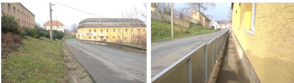
Obrázek 8: Vlevo – pohled na sil. III/42213 od obecního úřadu. Vpravo – nevyhovující chodník.
