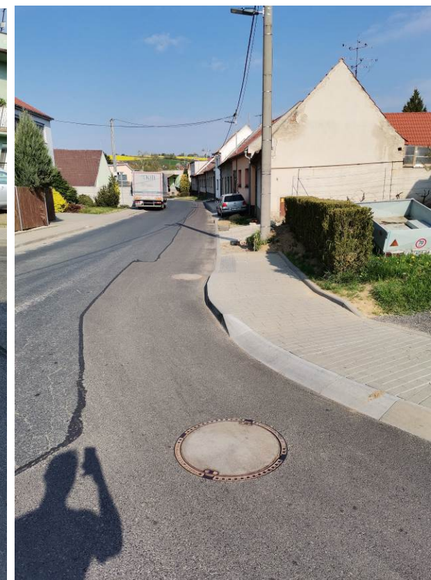
Nové šachty na stoce A
